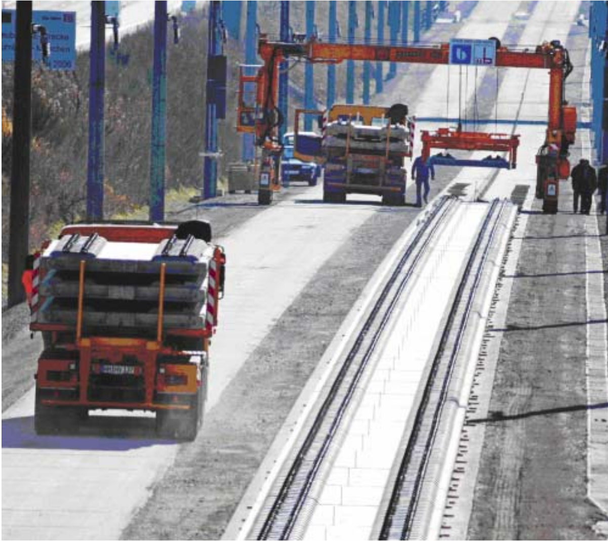
Abbildung 2: JIS Anlieferung beim Einbau von Feste Fahrbahn Elementen
