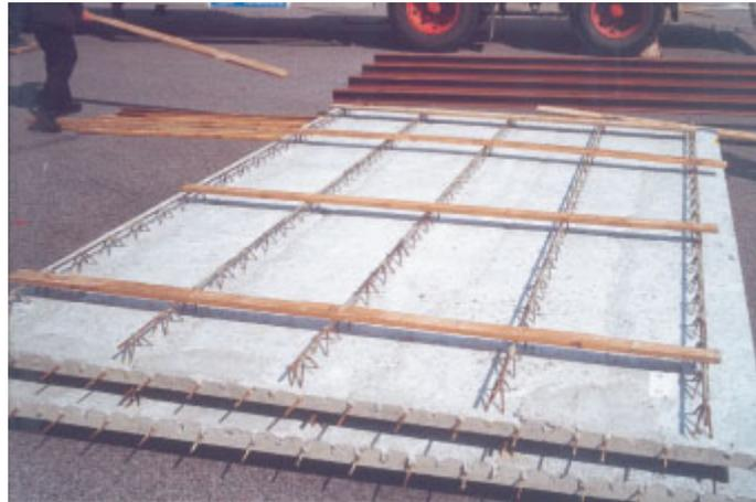
**Abbildung 2: Elementdeckenplatten aus Beton mit Holzwischenlage**
